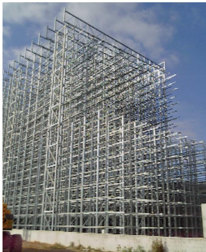
Sono circa 24 i metri di altezza del magazzino Ambrovit, per una superficie circa 3.000 mq, dove sono installati 4 traslo-elevatori mono-colonna che veicolano i pallet in circa 15.000 celle predisposte.
