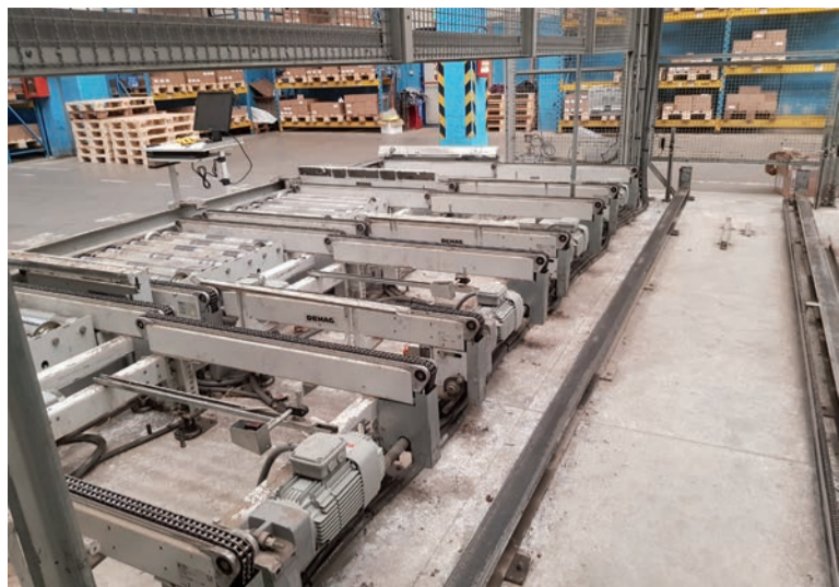
Ogni motore elettrico è stato aperto, sono state smontate le scatole di giunzione, verificati i cavi elettrici, controllata l'ossidazione e l'arrugginimento delle parti metalliche e il deterioramento delle parti magnetiche. In foto, il sistema ripristinato
